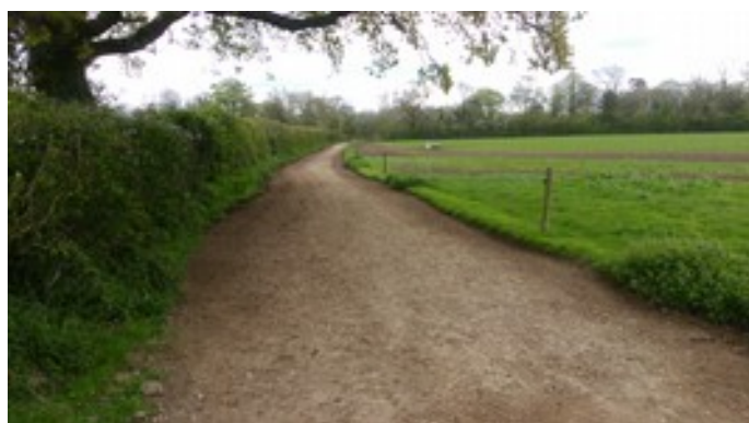
Chemin compacté avec de la chaux
