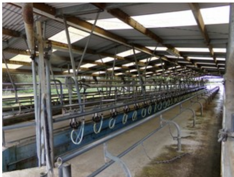
Vue d'ensemble de la salle de traite
